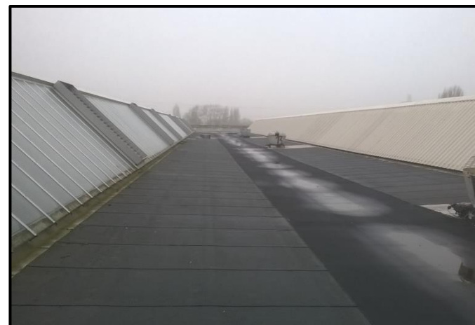
Photo 35 : Toit du bâtiment 7 (M.Mariné)
